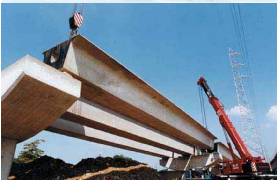
Fasi della posa in opera delle travi da ponte.
