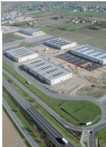
MEGALOPOLI Una veduta aerea dell'outlet in costruzione a Roncade
