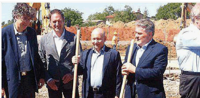
La posa della prima pietra alla casa di riposo di Torre di Mosto
